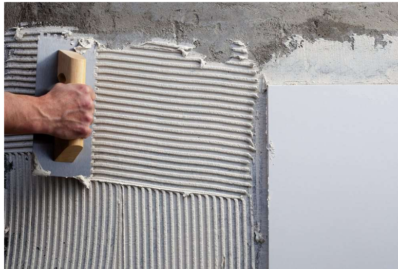
Figura 87 – Aplicação de argamassa colante com desempenadeira dentada.
